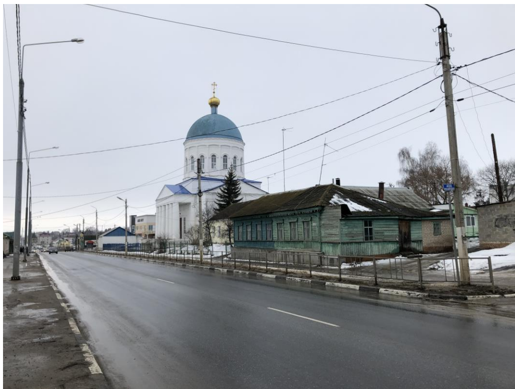
Фото 21. СВД.1. Сектор восприятия раскрывается в сторону объекта культурного наследия регионального значения «Церковь Николая Чудотворца» с противоположной стороны ул. 25 Октября в западном направлении.
