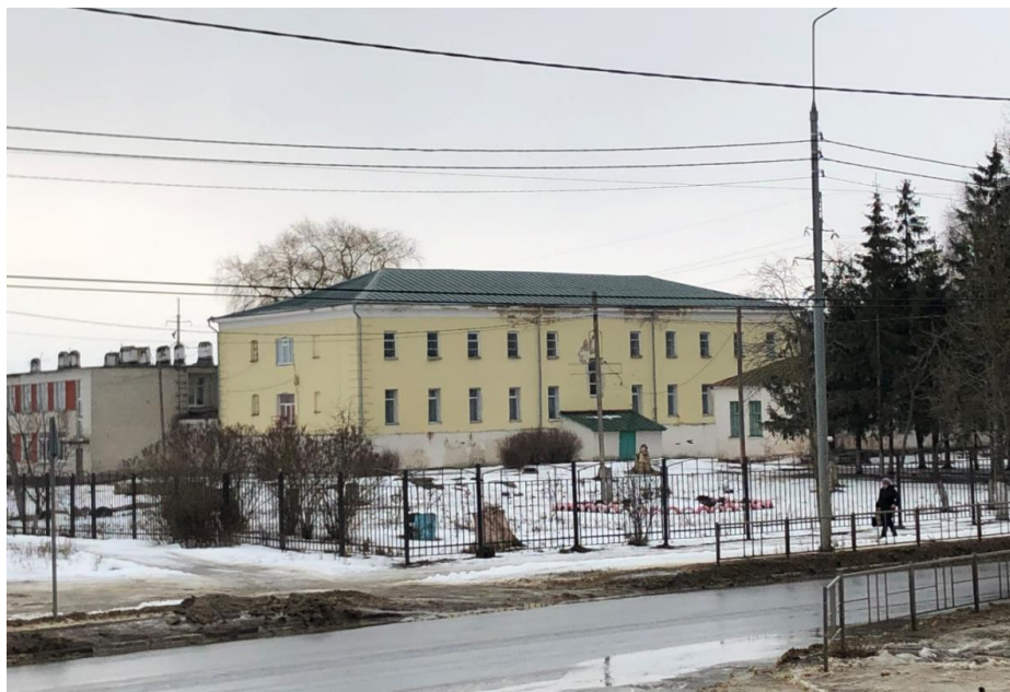
Рис.28. Фотофиксация объекта культурного наследия «Здание бывшей уездной тюрьмы», январь 2021 год.
