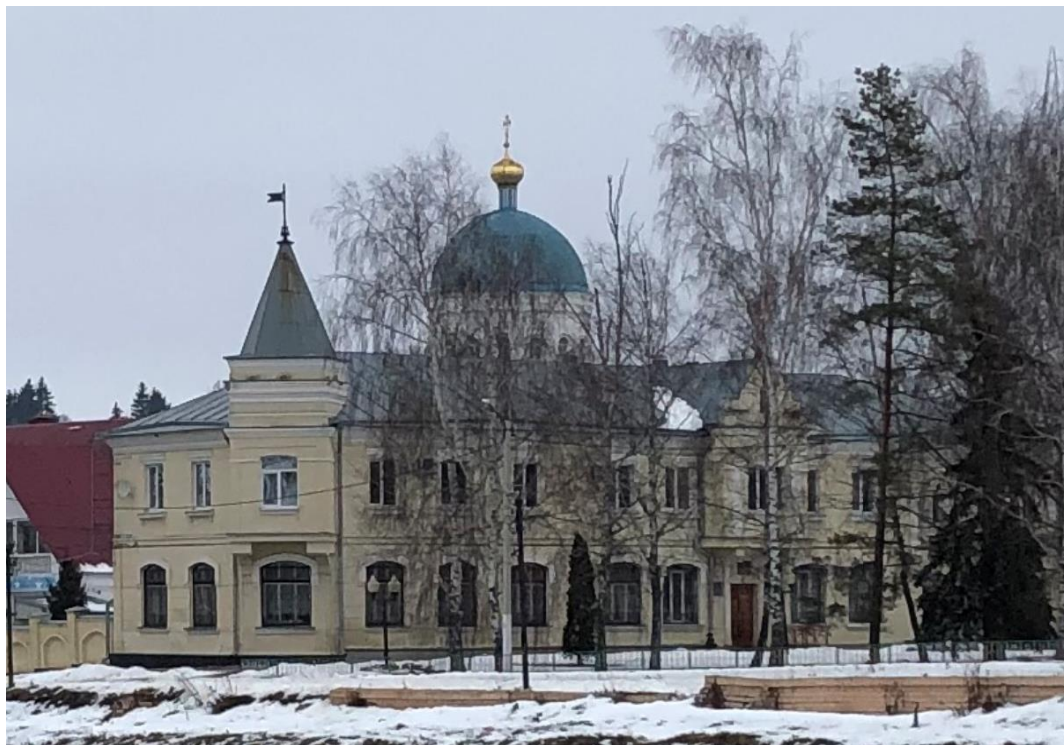
Фото 21. Фотофиксация объекта культурного наследия регионального значения «Торговые ряды», январь 2021 год.
