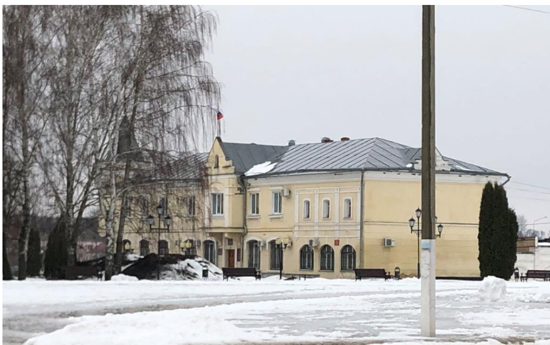
Фото 22. Фотофиксация объекта культурного наследия регионального значения «Торговые ряды», январь 2021 год.
