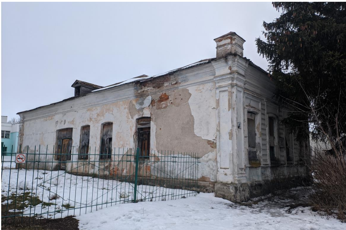
Фото 19. Фотофиксация объекта культурного наследия регионального значения «Здание бывшего женского начального училища, в котором преподавал ученый Куренцов Алексей Иванович», январь 2021 год.
