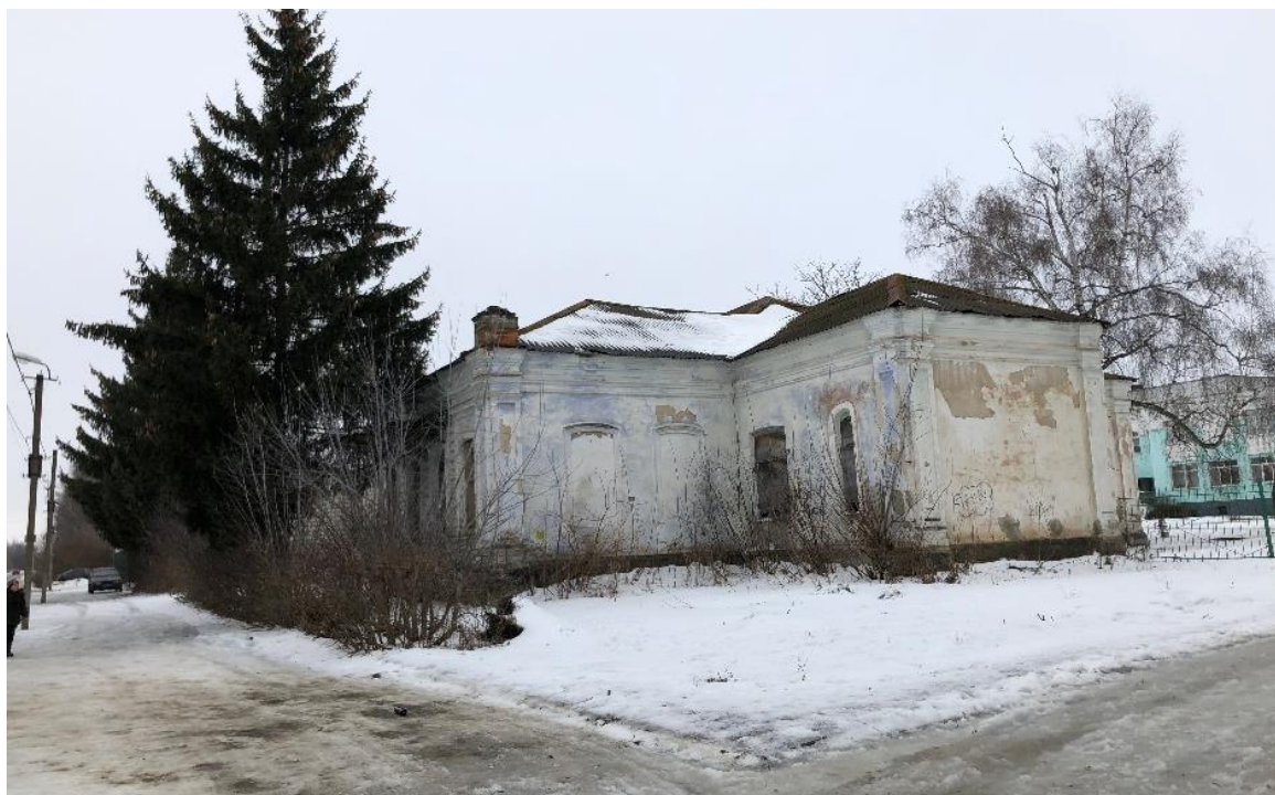
Фото 18. Фотофиксация объекта культурного наследия регионального значения «Здание бывшего женского начального училища, в котором преподавал ученый Куренцов Алексей Иванович», январь 2021 год.
