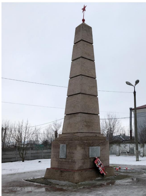
Фото 4. ТВ.4. Видовое раскрытие идет с стороны ул. 25 Октября в юго-западном направлении на объекты культурного наследия регионального значения «Братская могила борцов, погибших за установление Советской власти в Кромском уезде» и «Братская могила мирных жителей, расстрелянных фашистами».
