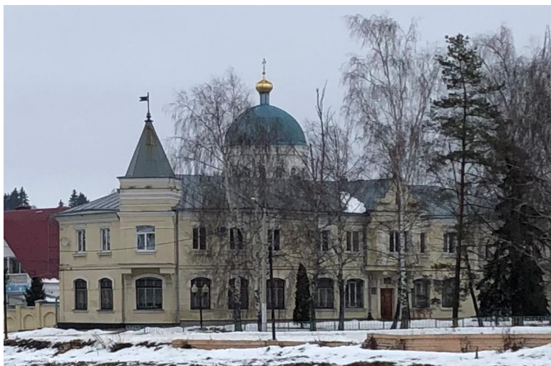
Рис.30. Фотофиксация объекта культурного наследия «Торговые ряды», январь 2021 год.
